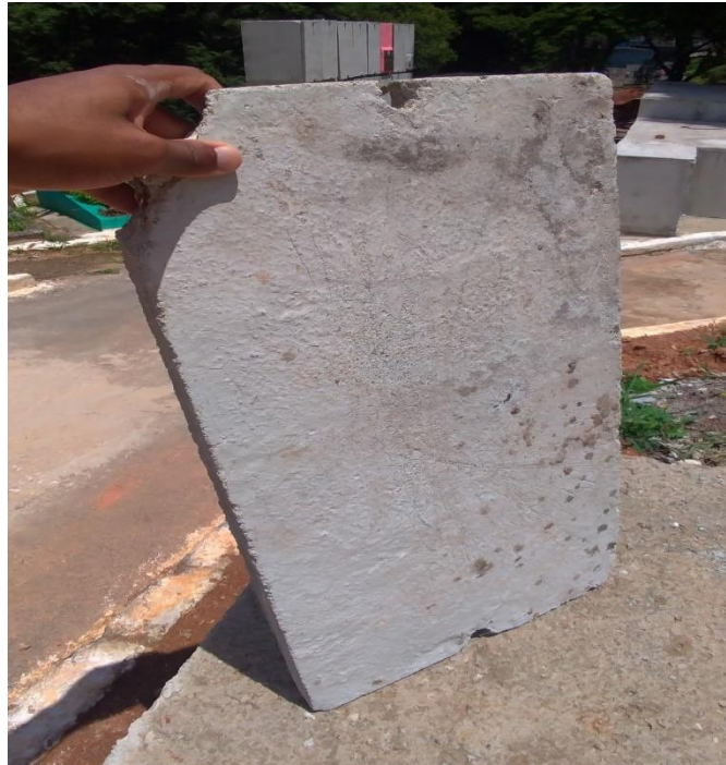
Tampa da caixa de concreto.
