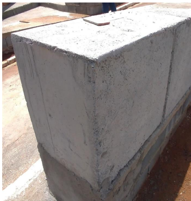
Caixa de concreto.
