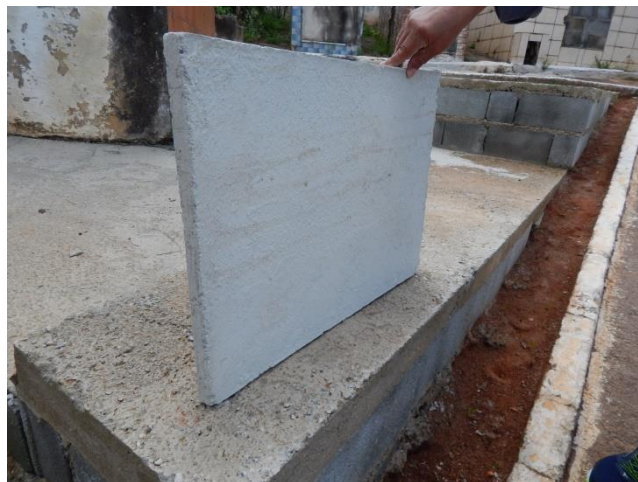
Divisória da caixa de concreto.
